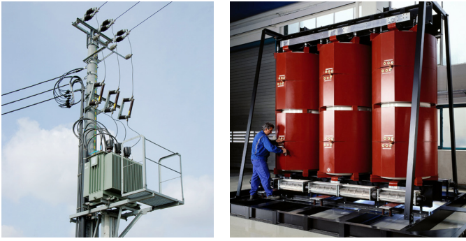
Transformadores típicos, líquido (izquierda) y seco (derecha)
